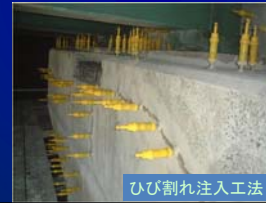
ひび割れ注入工法
