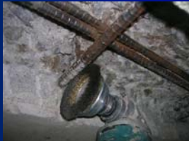
④鉄筋ケレン
