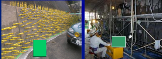
ひび割れ注入工
