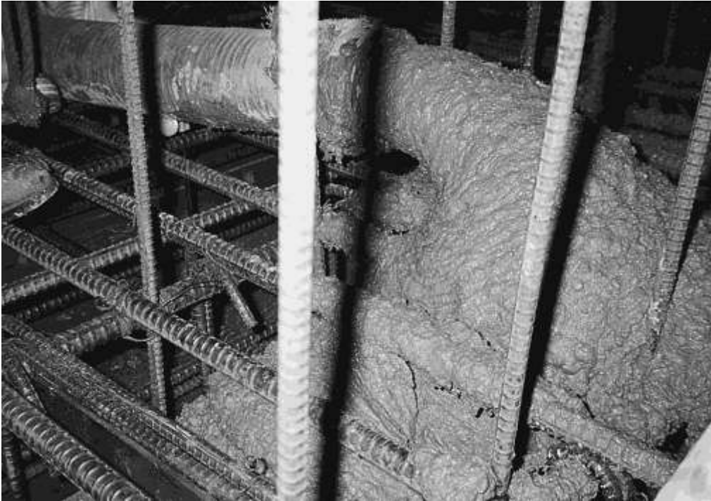
硬練りコンクリート
