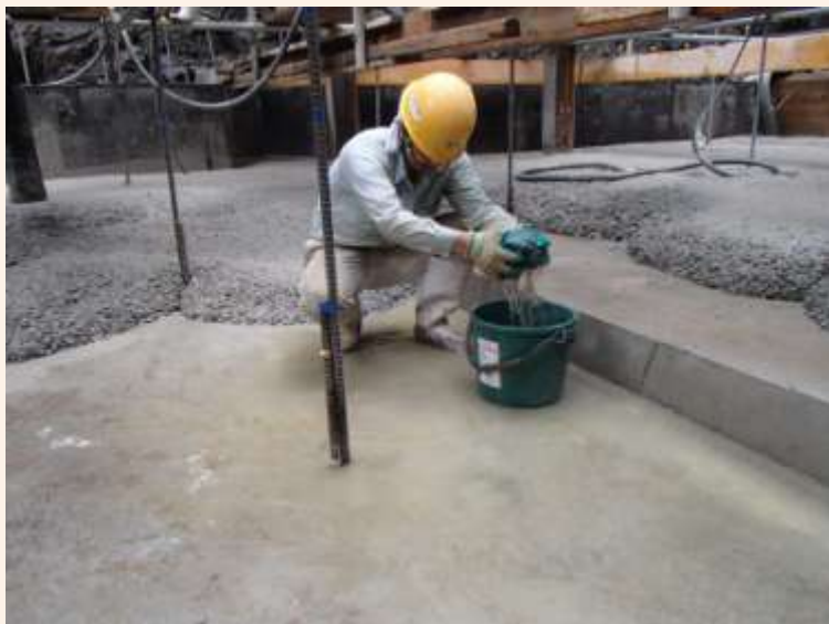
打設中のブリーディング水回収
