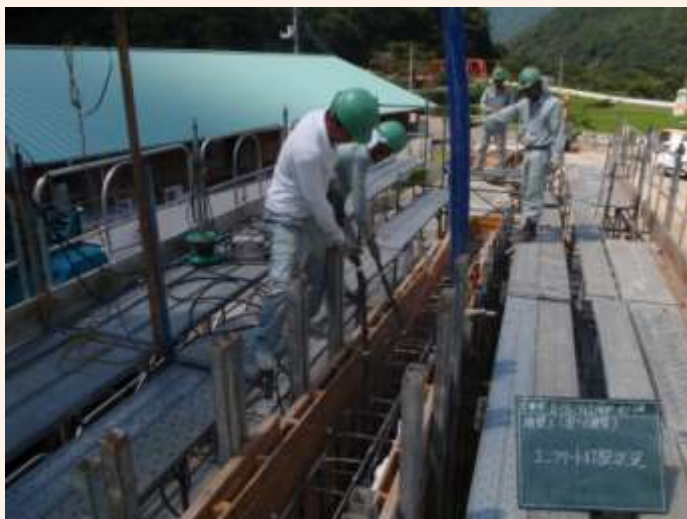
筒先を挿入し、落下速度を抑えている
