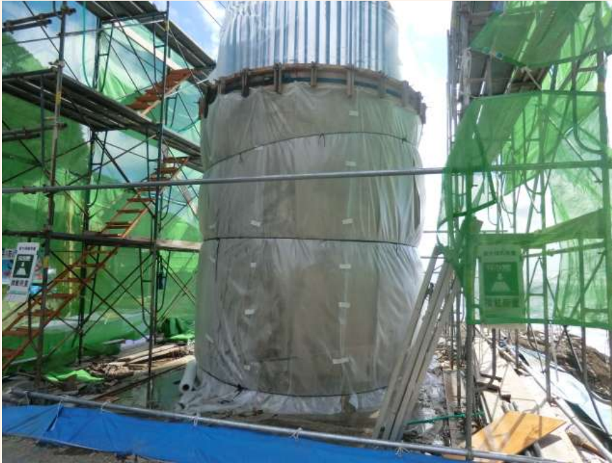
橋脚の養生における気泡緩衝材の使用
