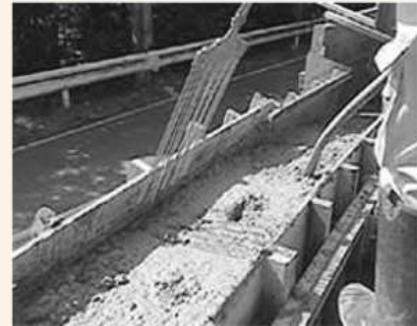
スパージングによる気泡の除去
