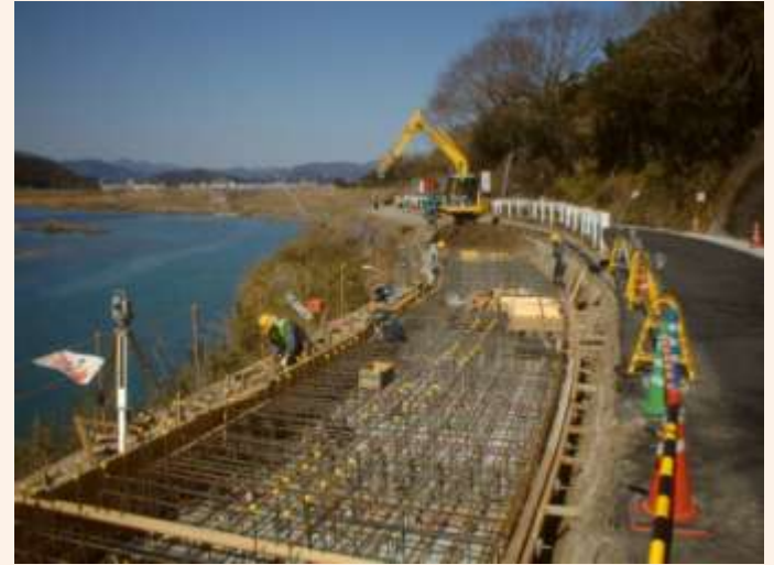
現道交通供用下のコンクリート工事
