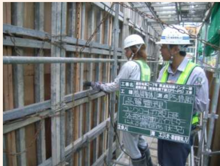
型枠振動機の使用
