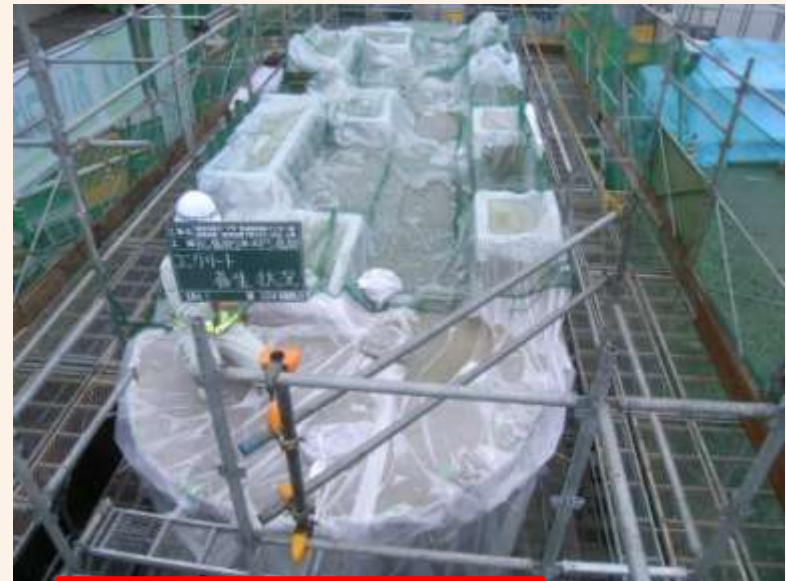
堪水養生+シート養生
