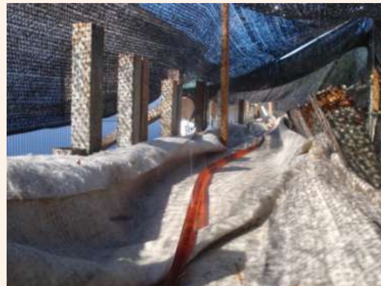
暑中コンクリートでの養生
