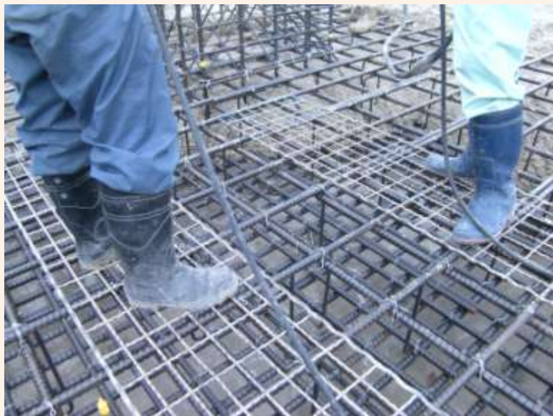
金網マット、鉄筋上面の作業性確保
