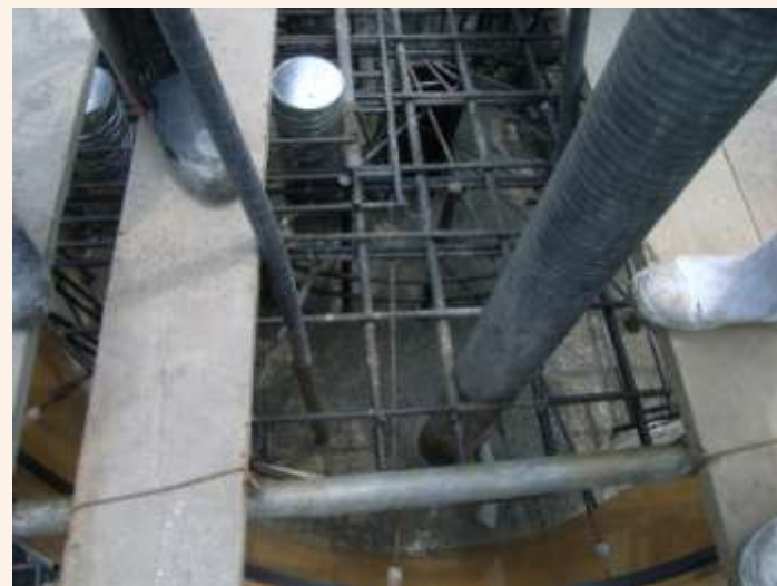
打設高さ、締固め高さはできるかぎり直下がよい
