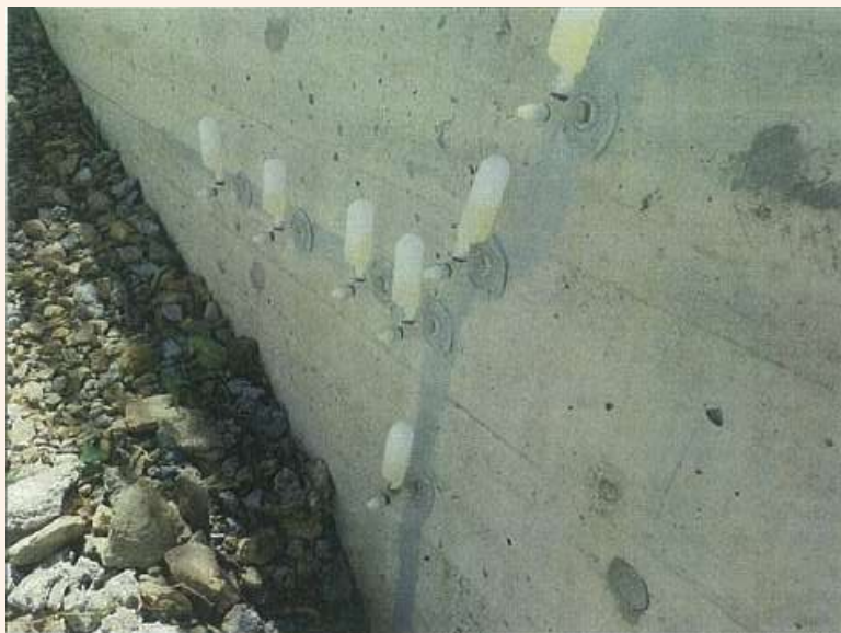
温度ひび割れの発生、補修状況
