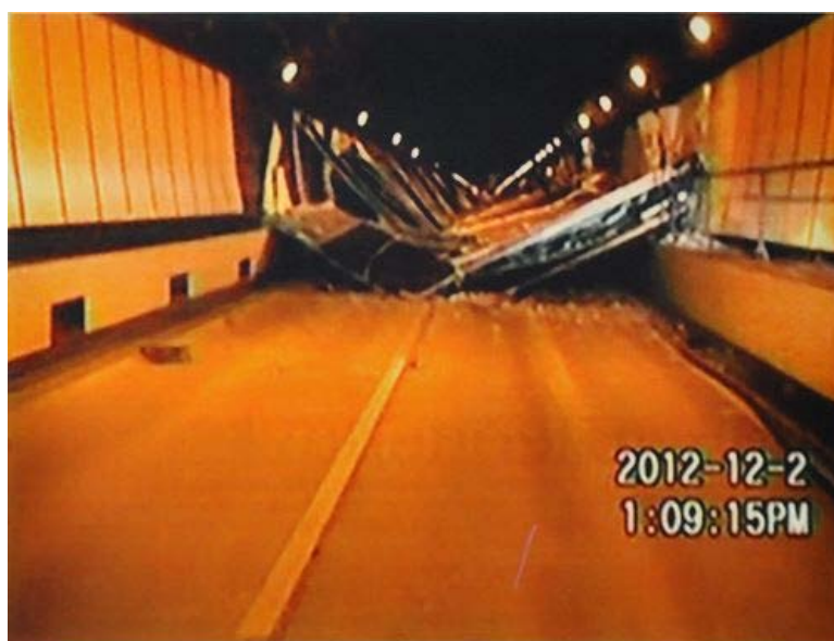
図-3 崩落事故があった中央道・笹子トンネルの内部（大月市側から撮影）＝山梨県警提供 ( http://mainichi.jp/graph/2012/12/02/20121202org00m040002000c/034.html から)
