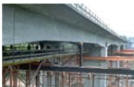
図-13 橋梁における床板、橋桁の変位モニタリング
