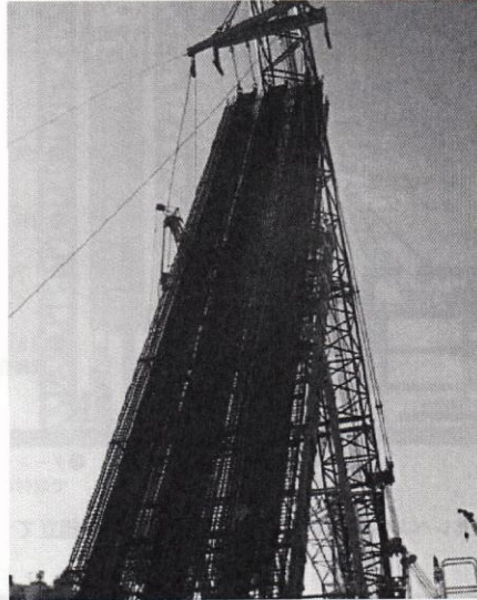
写真-4 節付き壁杭の鉄筋籠の建て起こし (08年12月)
