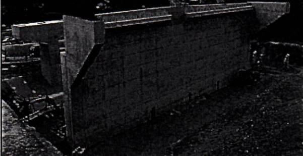
写真16 構造の一体性を考えると誘発目地は入れたくない橋台たて壁
