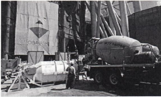
写真-10 コンクリートを圧送エリアまで輸送するバケット
