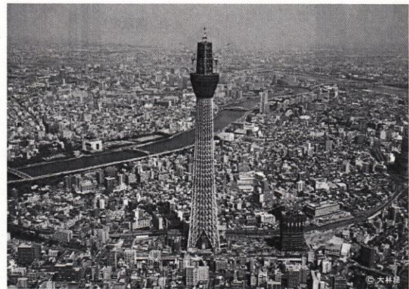
写真-1 東京スカイツリーの建設状況
