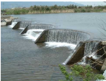
写真-1 旧神戸堰のアーチ部
