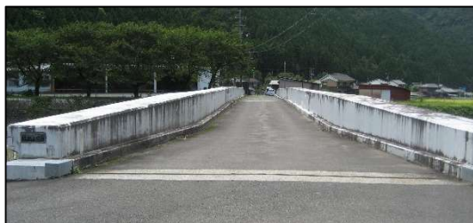
写真 4.1 右岸側橋面状況(被覆材の汚れ)
