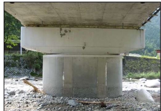
写真 4.4 橋脚の現在の状況
