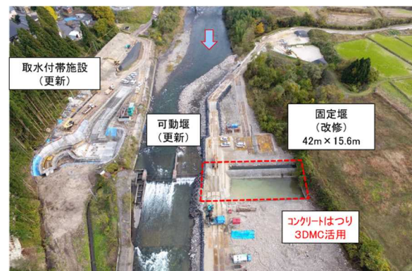
写真-1 頭首工改修工事全景
