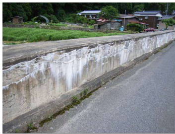
写真 2.3.1 L側桁部内側の状況
