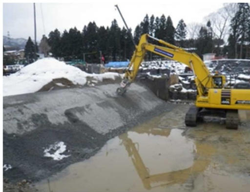
写真-3 ICT建機による固定堰はつり状況
