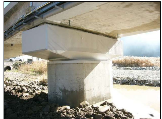
写真 3.2.1 橋脚補修工事完了
