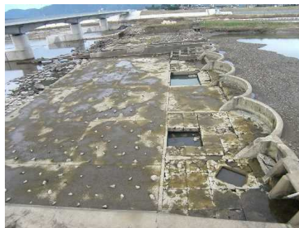
写真-2 取壊し前 左岸より
