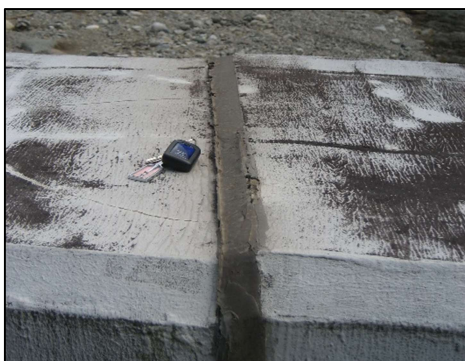
写真 4.3 橋脚上主桁目地止水状況
