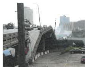
ミネアポリス橋 40年後崩落
