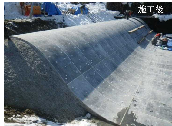
写真-2 固定堰 施工前と高強度パネル施工後
