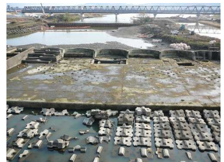
写真-3 取壊し前 下流より
