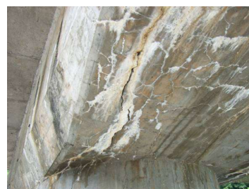
写真 2.3.6 橋脚梁部R側下面
