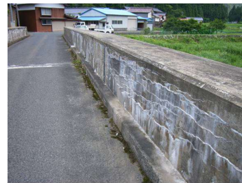
写真 2.3.2 R側桁部内側の状況
