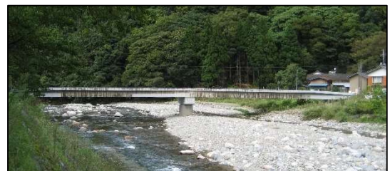
写真 4.2 上流側側面状況
