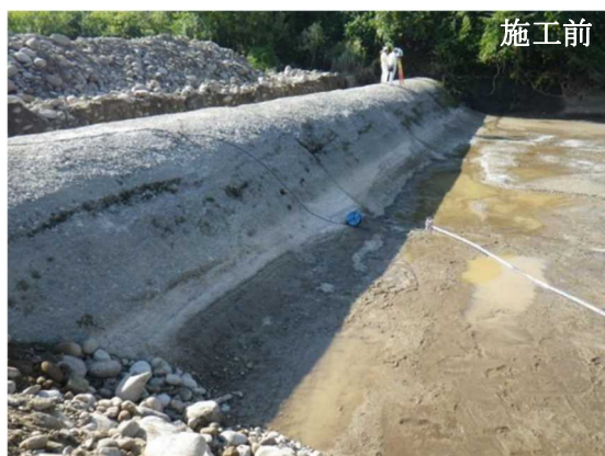
写真-2 固定堰 施工前と高強度パネル施工後
