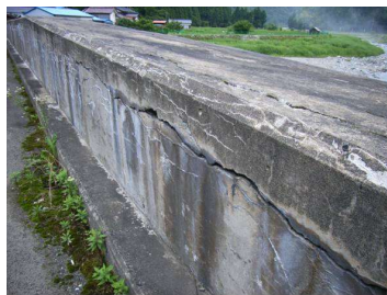
写真 2.3.3 R側桁部内側の状況
