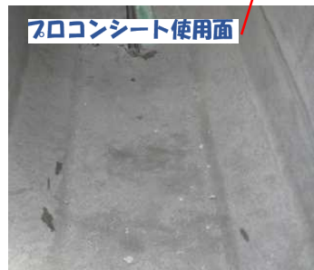
コンクリートの仕上り面
