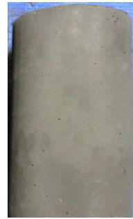
フロコンシート貼付け
