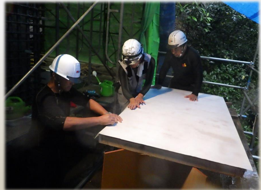
現場でしわにならないよう貼付け
