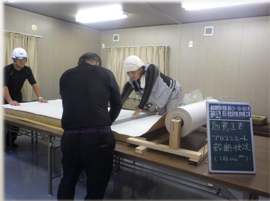
裁断口を無くすため製作台を設置
