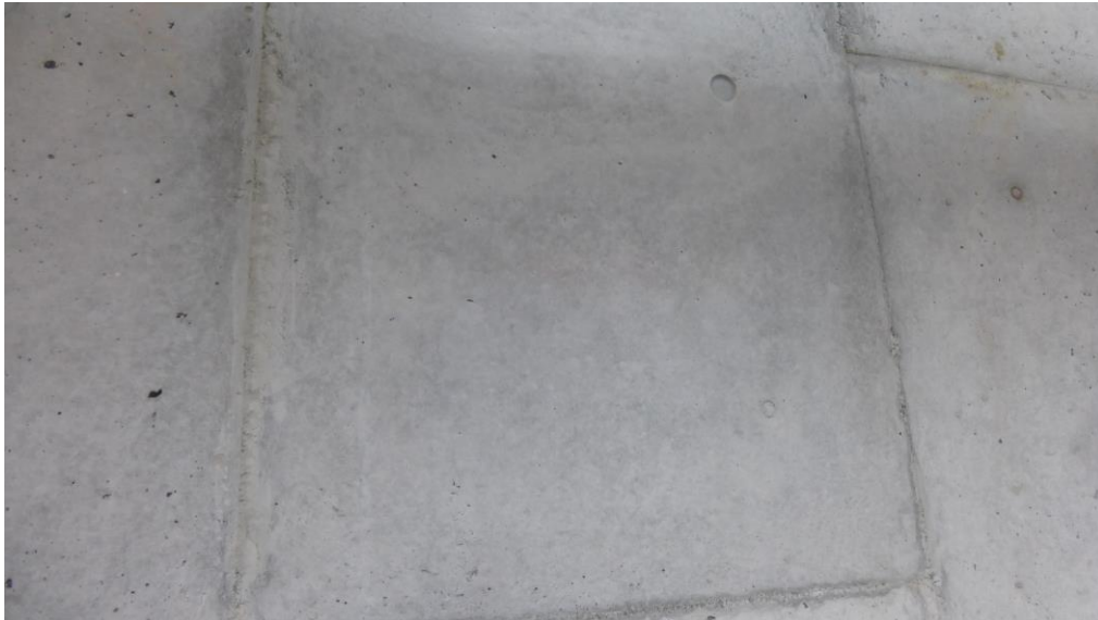
透明性型枠部の脱型後の コンクリート表面
