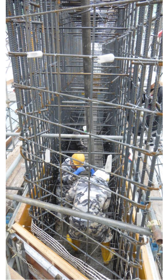
打設作業状況 (躯体部)
