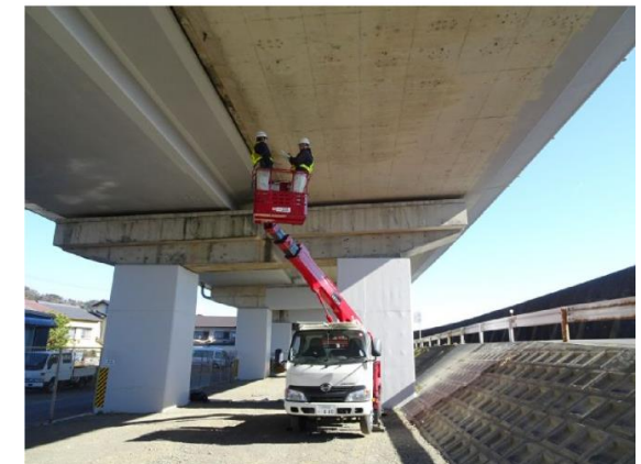
橋梁点検車による直接目視 出展：国土交通省HP
