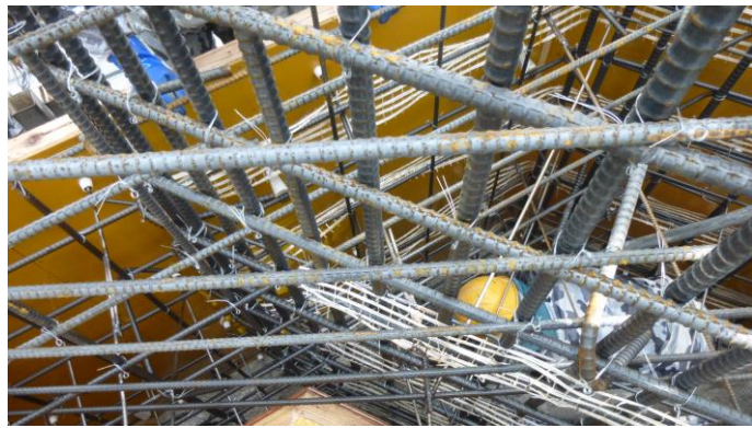
打設作業状況 (ウイング部)
