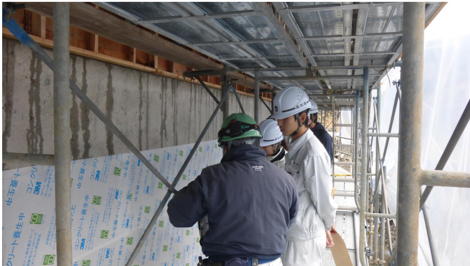
脱型後のコンクリート養生及び表面の出来栄え評価と見学
