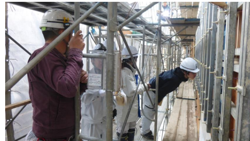
透明型枠を通したの打設状況見学
