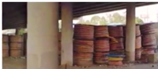
資材が積まれていた桁下の状況
