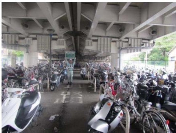
桁下利用状況
