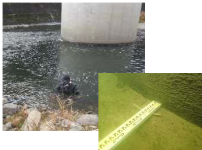
潜水調査による河床洗掘の把握
