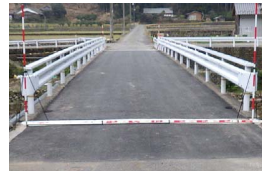
橋面舗装補修:補修後
