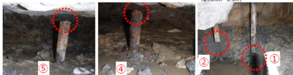
【鉛直PC鋼材の破断状況】
