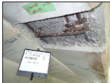
断面修復: 施工前
