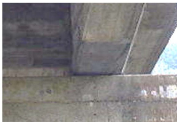
断面修復:補修後
