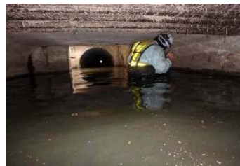
滞水した溝橋内部の目視点検
