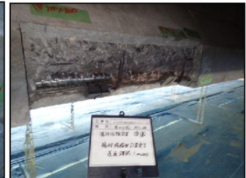
電気防食: 施工後
