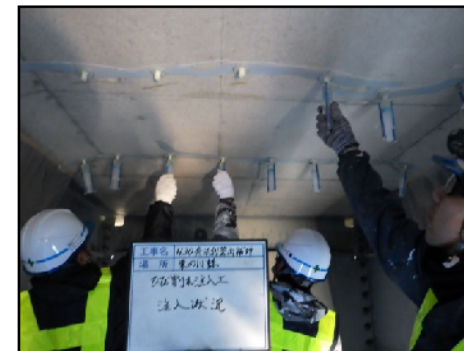
ひび割れ注入: 施工中
