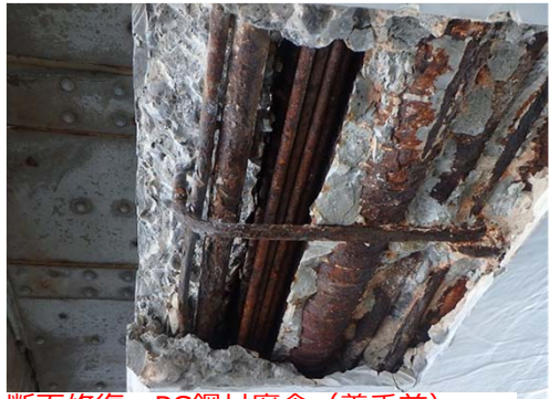
断面修復・PC鋼材腐食（着手前）
