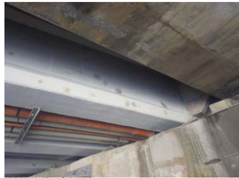
断面修復（完了）
