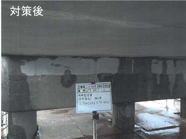
【断面修復工、ひびわれ補修工】
