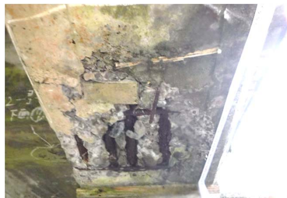
断面修復:補修前
