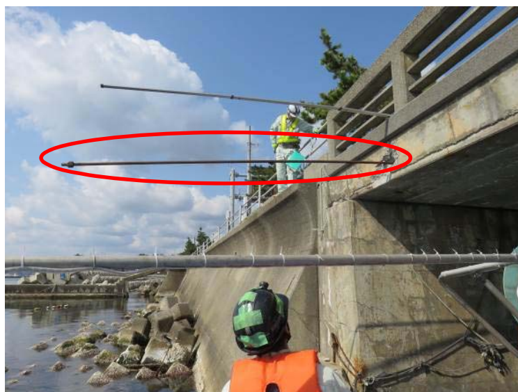
【横締PC鋼棒の突出】
