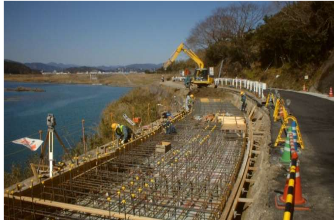
現道交通を供用しながらのコンクリート工事
