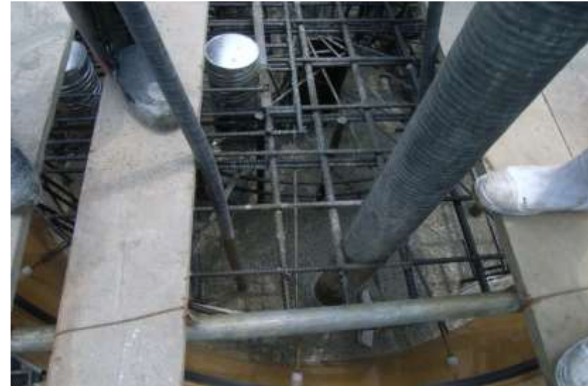
打設高さ、締固めはできるかぎり直下がよい
