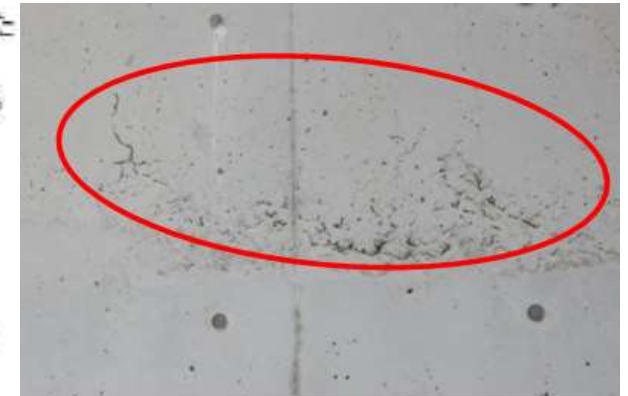
【ボックスカルバート側壁】
