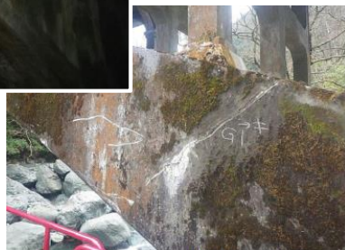
【上部構造（主桁）】 ・ひびわれ、鉄筋露出 ・判定区分Ⅲ
