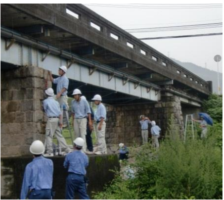
▲現地見学 (上室川橋の損傷状況を確認)
