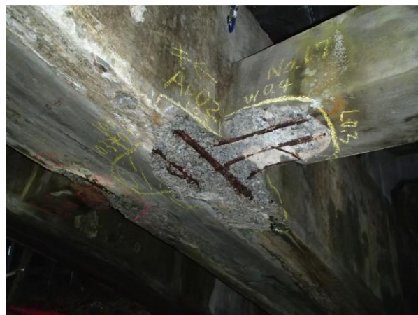
【上部構造（主桁）】 ・ひびわれ、鉄筋露出 ・判定区分Ⅲ
