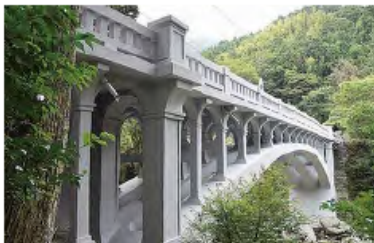
修繕後の大宮橋
