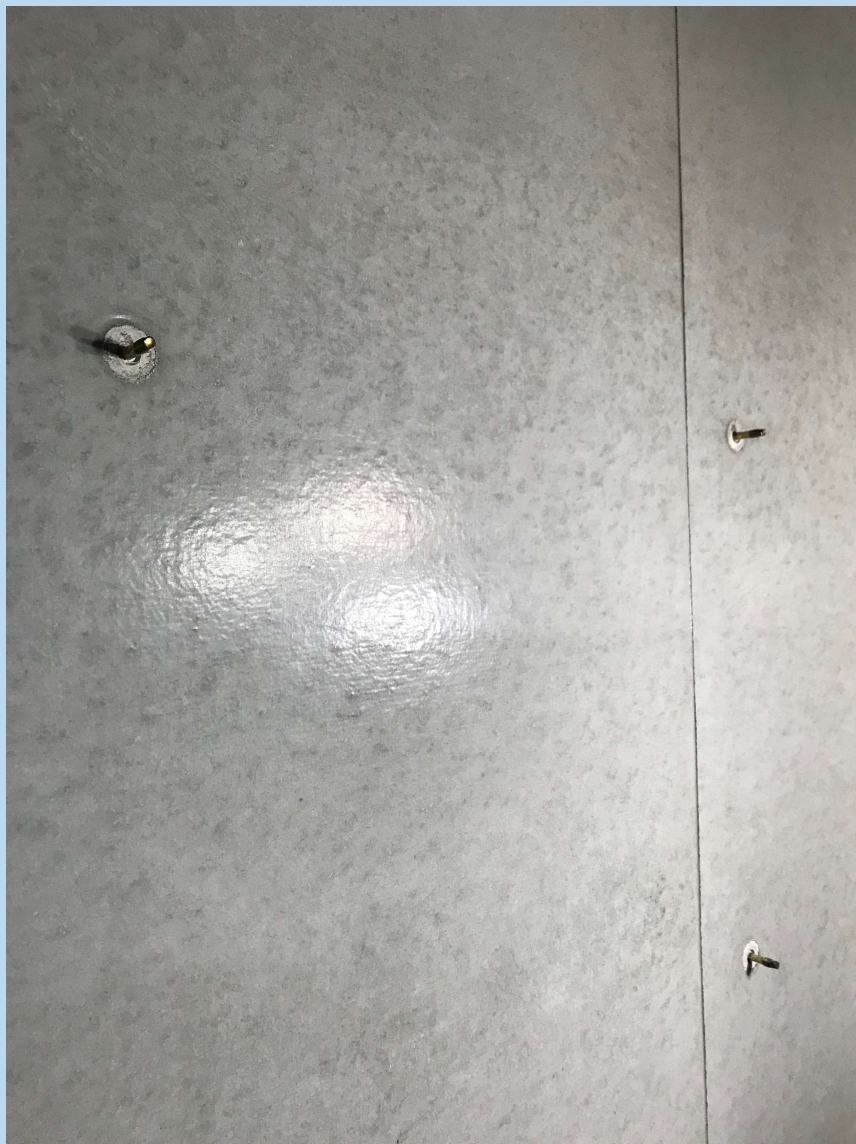
プロコンシート®一般用使用コンクリート面 (現場型枠解体後ピンホール無し)
