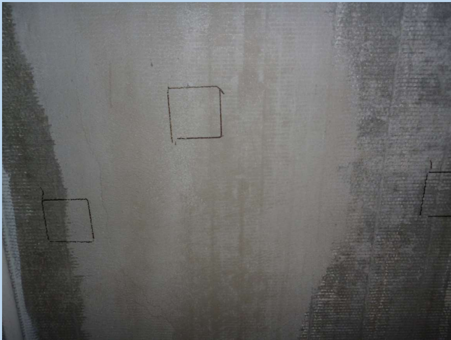
プロコンシート部分補修箇所
