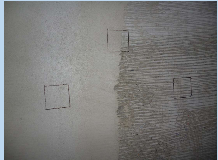
超高压水洗浄部分補修箇所
