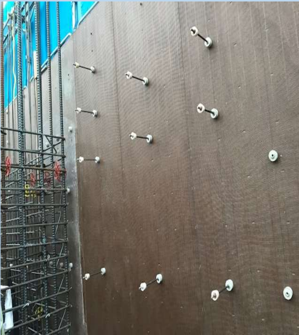
プロコンシート®(タイル下地用)型枠建て込み
