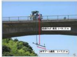
「橋梁点検カメラシステム視る・診る」による近接目視、打音調査等援助・補完技術
