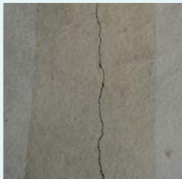
プライマー塗り跡
