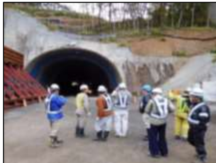
小樽JCT工事(トンネル部・H27)
