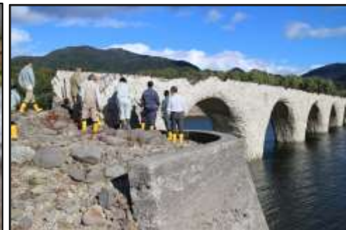
タウシュベツ川橋梁(H26)
