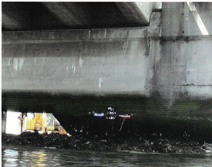
橋梁下部撮影風景
