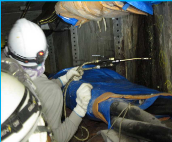
2ショットノズルによる注入状況写真
