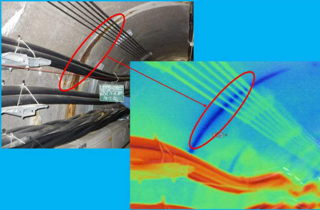
補修前のサーモグラフィック写真
