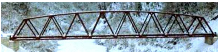
(b) トラス橋(写真)
