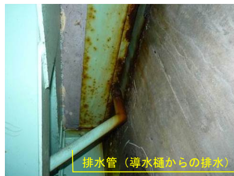
伸縮装置の下から見上げたところ
