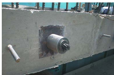
施工時の健全な状態の定着部
