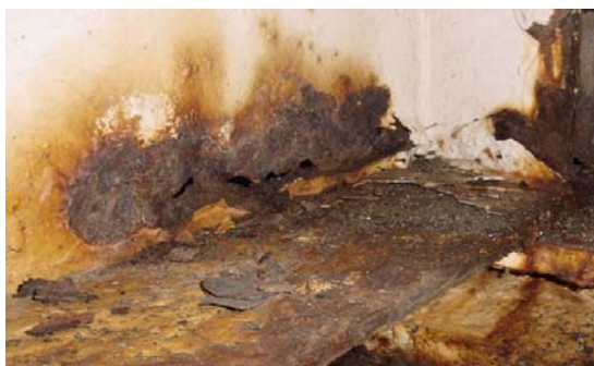
写真-5.1.25 鋼橋の腐食の診断における留意点
