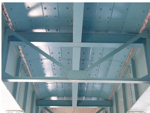
(a) 鋼板接着補強
