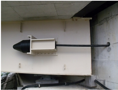
ケーブルを用いた事例
