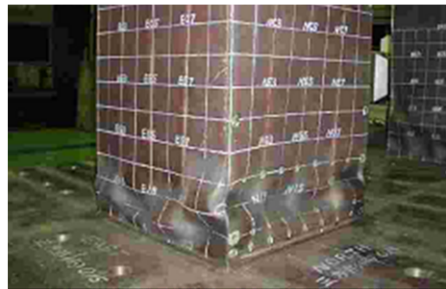
(a) 圧縮フランジの局部座屈
