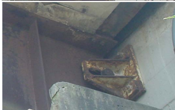
写真-5.3.3 遊間の異常の診断における留意点
