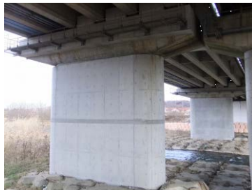
写真-5.2.39 耐震補強 (分類3: コンクリート巻立て)
