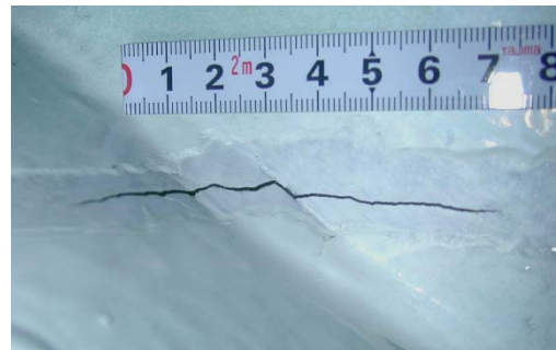
磁粉探傷試験後（塗膜厚除去後）
