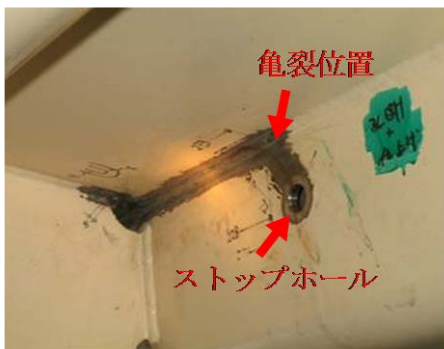
写真-5.5.10 鋼部材へのストップホールの例 (亀裂部の塗膜を除去した後)
