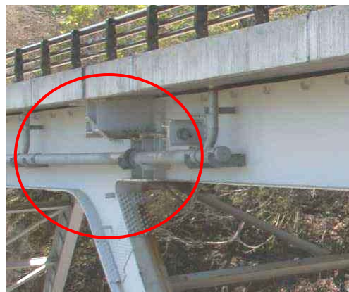
図-2.4.39 ラーメン橋隅角部
