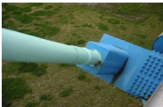
写真-5.4.6 定着部の異常の診断における留意点
