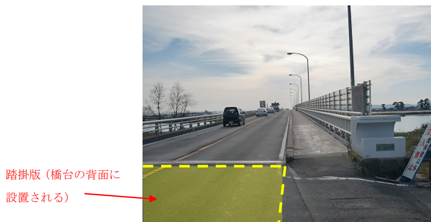
図-2.2.72 橋台背面の踏掛版
