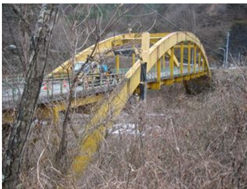
図-2.4.33 中路式アーチ橋
