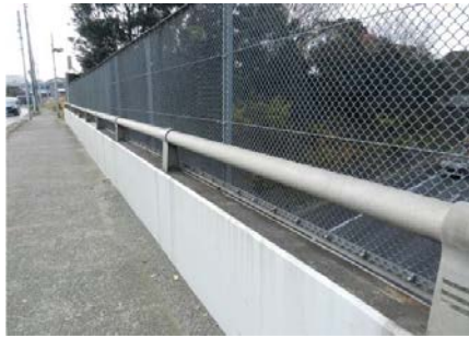
図-2.3.13 落下物防止柵の例
