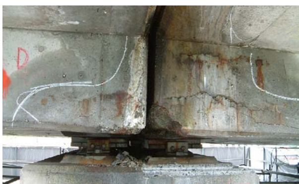
写真-5.2.17 ひび割れの診断における留意点
