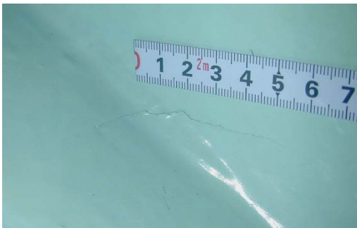
磁粉探傷試験前（塗膜厚除去前）
