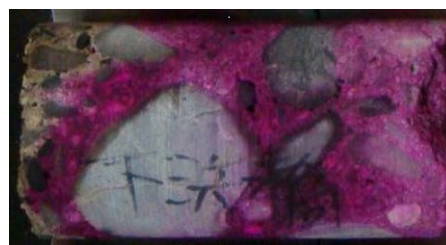
写真-5.2.4 フェノールフタレインによる調査例（コア）
