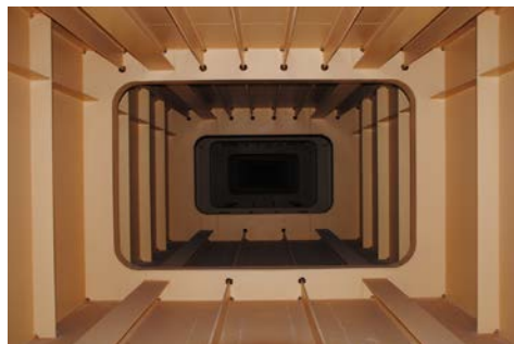
鋼箱桁内部断面
