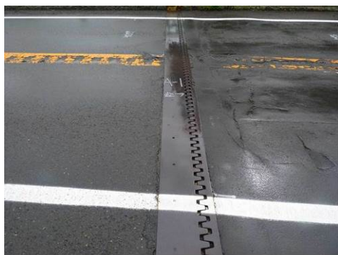
橋面から見たところ
