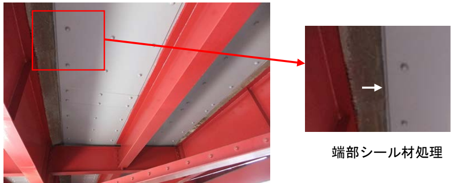
図-2.2.36 鋼板接着補強
