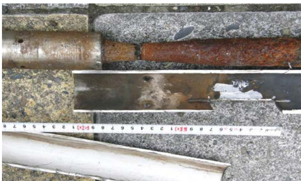
写真-5.1.23 鋼部材の腐食の診断における留意点
