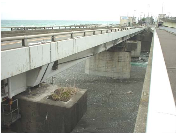
図-2.4.54 PCT 桁橋 (外ケーブル補強)
