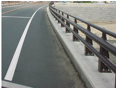
(c) 橋梁用ビーム型防護柵の例
