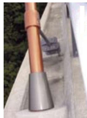
写真-18.4 斜張橋の定着部の例 (注：健全な状態)
