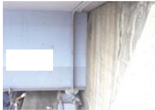
写真-25.5 橋台の移動に伴い伸縮装置の著しい移動と、主桁とパラペットの接触が生じた例
