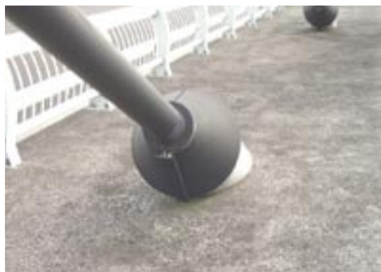
写真-18.3 斜張橋の定着部の例 (注：健全な状態)
