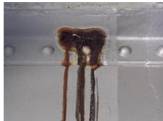
写真-1.3 メッキが施された鋼材に錆が発生した例
