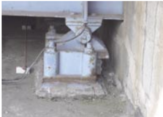
写真-25.5 橋台の移動に伴い伸縮装置の著しい移動と、主桁とパラペットの接触が生じた例
