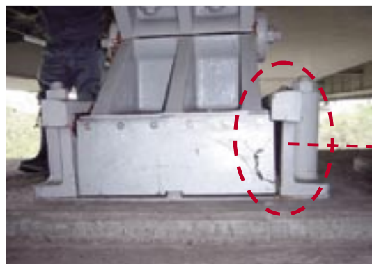
写真3.10 支承のロッカーローラーに傾斜が生じた例
