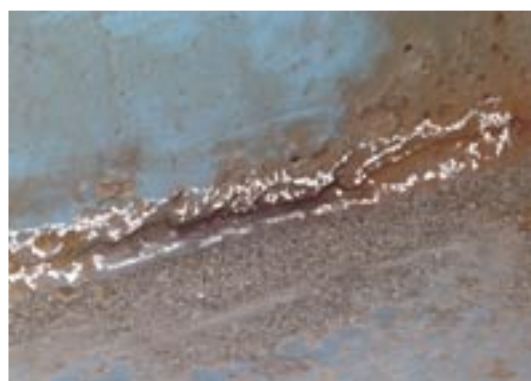
写真-1.13 腐食と同時亀裂を生じた例 (注: 亀裂箇所をチョークでマーキングしている)
