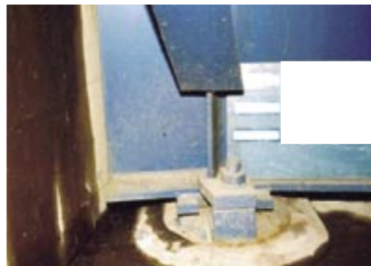
写真-13.2 主桁と橋台の接触、支承のピンチプレートのずれが生じた例
