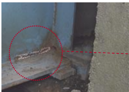
写真-1.13 腐食と同時亀裂を生じた例 (注: 亀裂箇所をチョークでマーキングしている)
