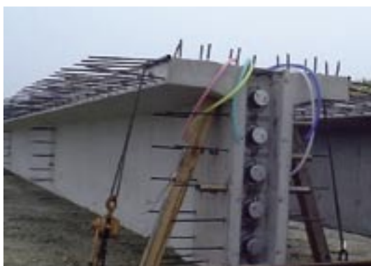
写真-18.9 PC縦締め定着具の例 (注：製作時の健全な状態)
