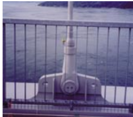
写真-18.6 吊り橋のハンガ一定着部の例 (注：健全な状態)
