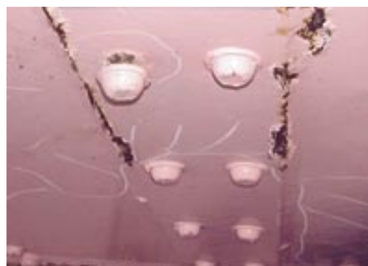
写真-10.3 床版の補強鋼板こうき，腐食が生じ，アンカーボルトに抜けが生じた例 (注：うき部分はチョークでマーキングしている)
