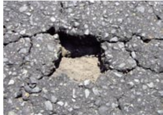
写真-15.6 舗装のひびわれとポットホールが生じた例
