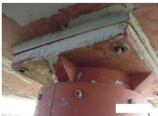
1) セットボルトの破断
