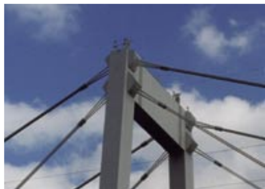
写真-18.5 斜張橋の定着部の例 (注：健全な状態)
