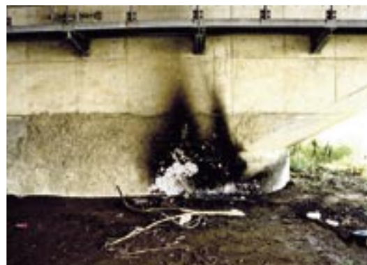
写真-17.4 火災による変色の例
