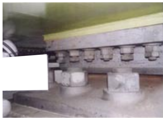
写真-3.6 ナットにゆるみが生じた例
