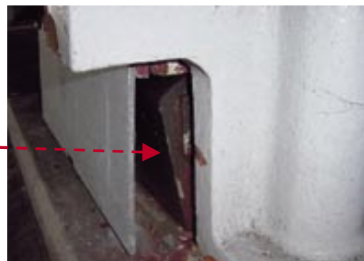
写真3.10 支承のロッカーローラーに傾斜が生じた例
