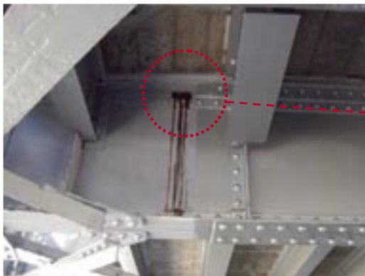
写真-1.3 メッキが施された鋼材に錆が発生した例
