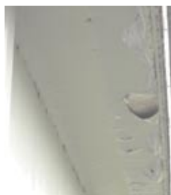
写真-10.4 張出し床版の塗装の剥がれが生じた例
