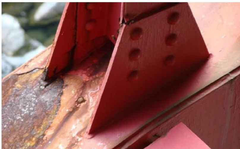
写真-5. 1. 29 鋼橋の腐食の診断における留意点 2116/06/25
