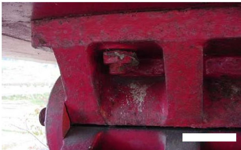
写真-5. 1. 49 ボルトのゆるみ・脱落の診断における留意点
