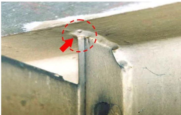
写真-5. 1. 34 鋼橋の亀裂の診断における留意点
