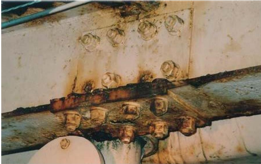
写真-5.1.53 ボルトのゆるみ・脱落の診断における留意点
