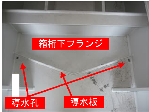
箱桁内部の導水板と導水孔 (縦断勾配の低い箇所に設置)
