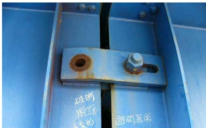
写真-5. 1. 50 ボルトのゆるみ・脱落の診断における留意点
