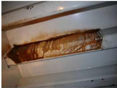
写真-5.1.43 鋼橋の亀裂の診断における留意点
