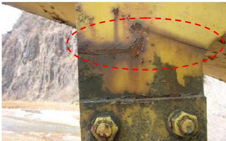
写真-5. 1. 42 鋼橋の亀裂の診断における留意点
