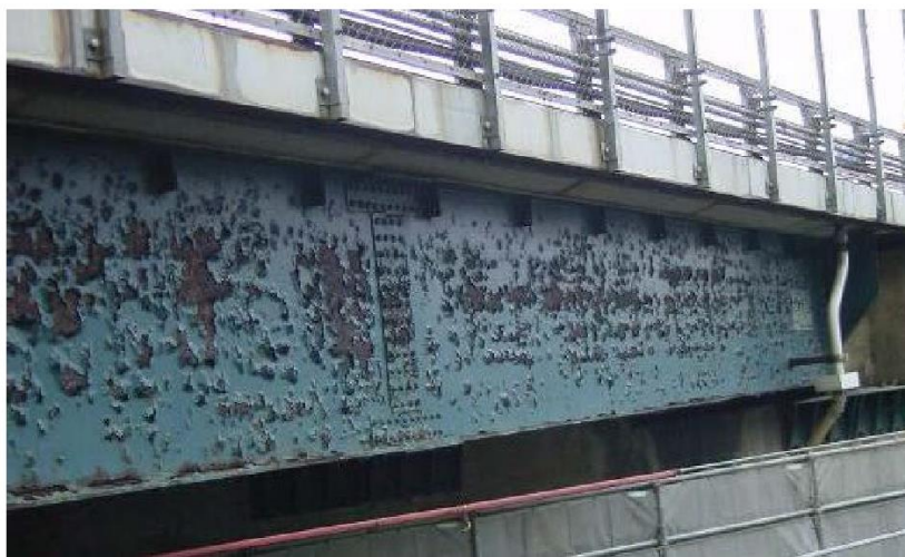
写真-5.1.14 鋼橋の防食機能の劣化の診断における留意点
