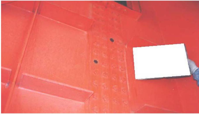
写真-5. 1. 51 ボルトのゆるみ・脱落の診断における留意点
