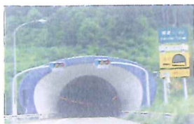
関越トンネル
